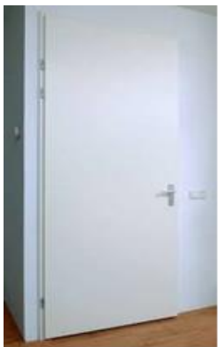
Hardhouten binnendeurkozijn zonder bovenlicht met opdekdeur
