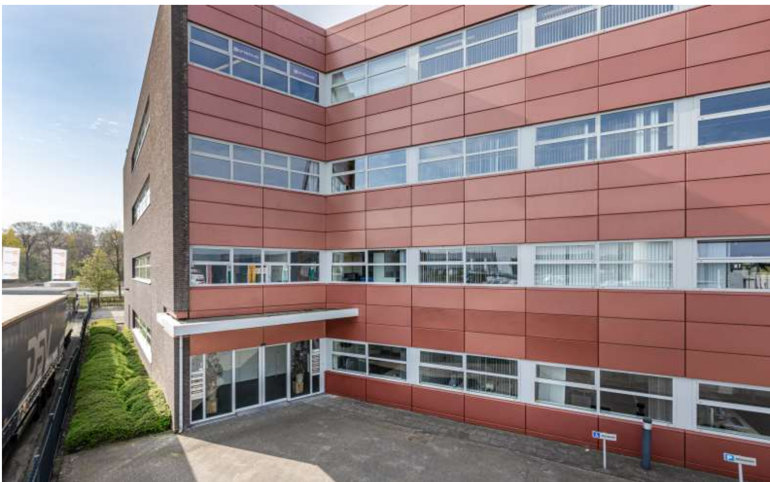
Het Schakelplein 10, 22 en 24 te Eindhoven
